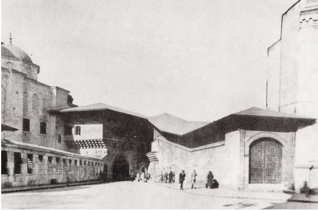
Figure 149. Yeni Cami pavilion, entrance ramp. From Nayır, Osmanlı Mimarlığında Sultan Ahmet. Külliyesi.
